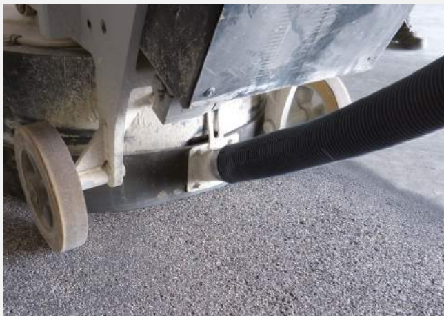
Maschine beim Stocken des Untergrunds
