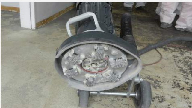
Stocken: Die dynamischste Form der Untergrundvorbereitung
