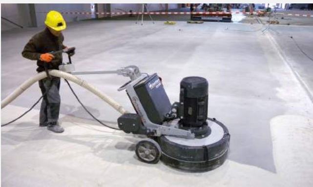
Großflächige Industriebodensanierung in einer Produktionshalle
