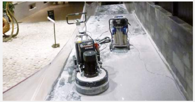
Marmorsanierung im Winterpalast, St. Petersburg
