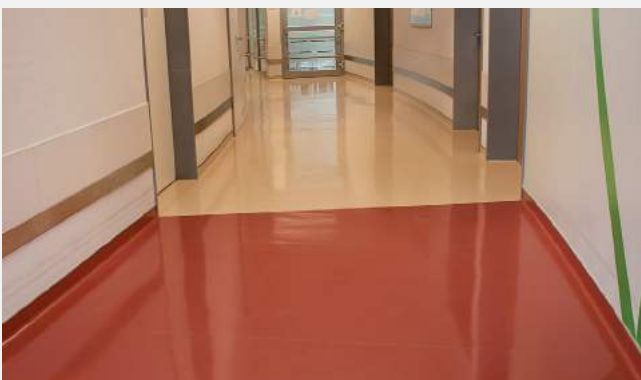
Pflegefilmsanierung des PVC Bodens der Kölner Uni-Klinik
