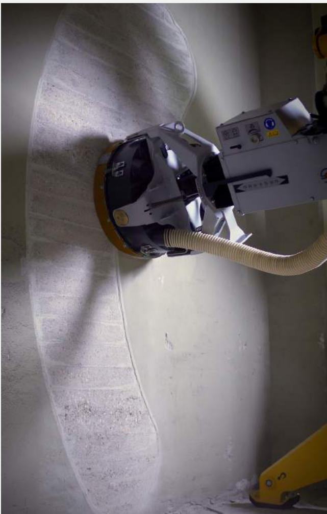
Entschichten – substanzschonend und Abraum reduzierend
