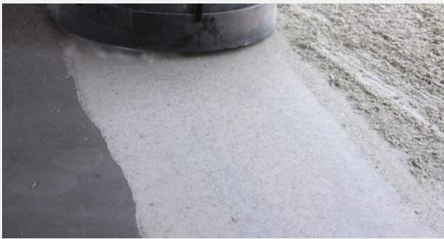
Natursteinsanierung am Flughafen von Oman
