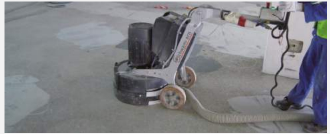
Gerade bei der Parkhaussanierung leistet Schwamborn ganze Arbeit
