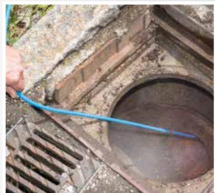
Fig. Flexible de nettoyage de canalisation
