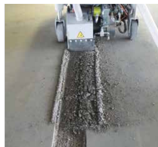
Oszillierendes Fräsen = geringes Betriebsgewicht
