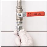
1. Montieren Sie den Hahnanschluss (0700) an den Wasserhahn.
