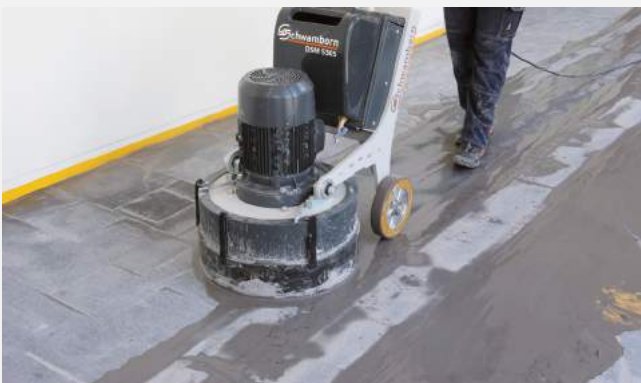
Betonsteinwerk wird mit der richtigen Schleiftechnik wieder wie neu
