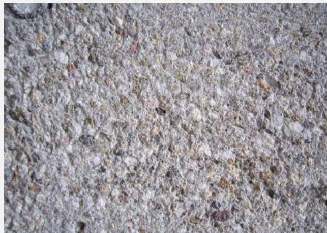
Ergebnis der Untergrundvorbereitung durch Stocken
