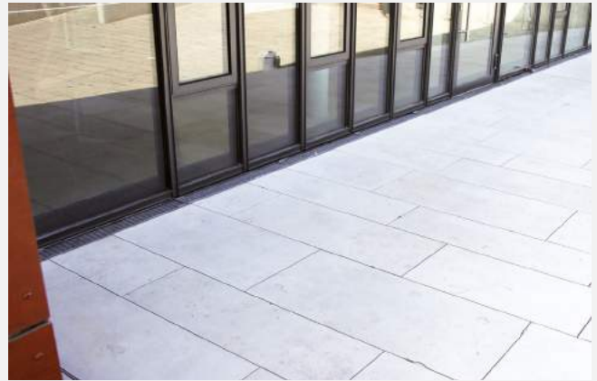
Nach der Bearbeitung mit Diamantbürsten, bleibt die Rutschfestigkeit erhalten
