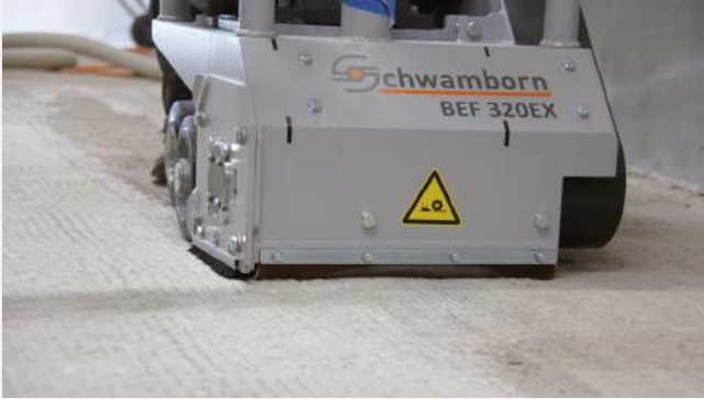
Fräsen: Tiefenwirksam und zum Ausgleich großer Höhenunterschiede
