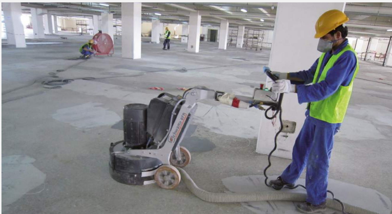
Schleifen in Kombination mit professioneller Staubabsaugung erzielte in internen Tests die besten Haftzugwerte
