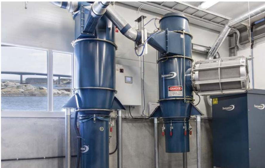
Dustcontrol liefert Filtereinheiten, die in der Zone 22 entsprechend den ATEX-Richtlinien 2014/34/EU installiert werden können.
