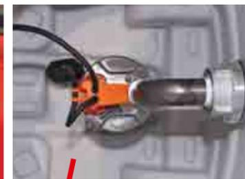
Schmutzwasserpumpe, schaltet sich über Schwimmerschalter automatisch Ein und Aus; kann für Außeneinsatz leicht demontiert werden
