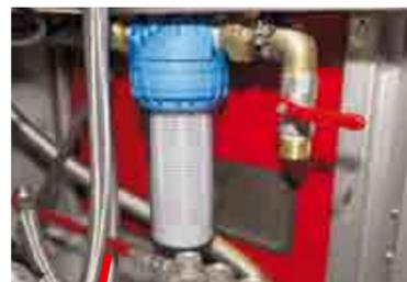
groß dimensionierter WassereingangsfILTER
