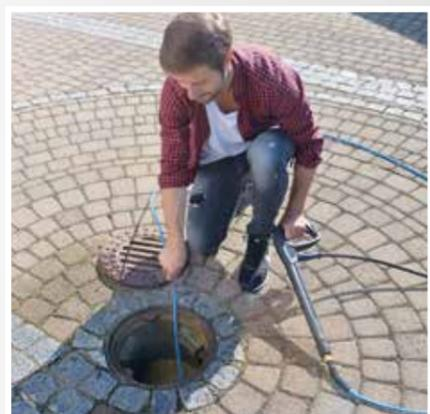
Fig. Flexible de nettoyage de canalisation
